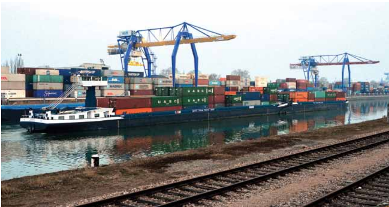
Mannheim container port
