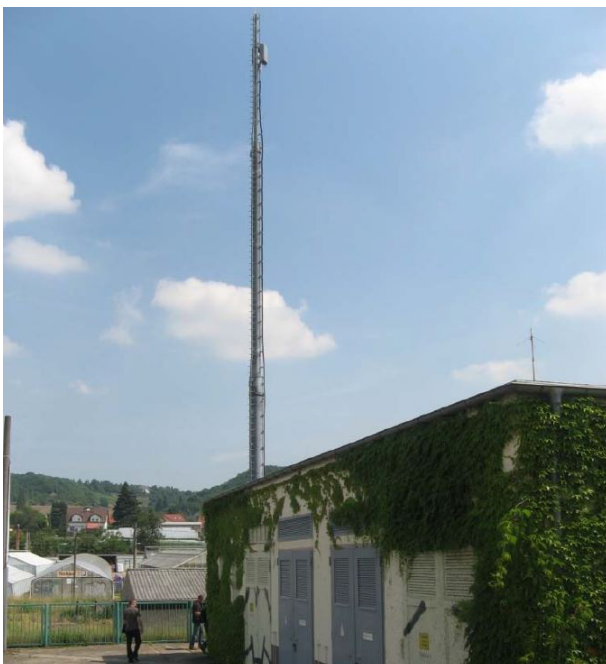
Abbildung 12: Bestehender Antennenmast als neuer Makrostandort für 5G Quelle: Dresdner Verkehrsbetriebe AG
