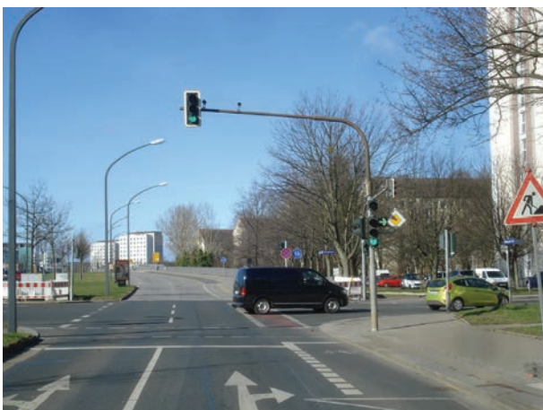
Abbildung 16: Lichtsignalanlage Quelle: Landeshauptstadt Dresden, Straßen- und Tiefbauamt
