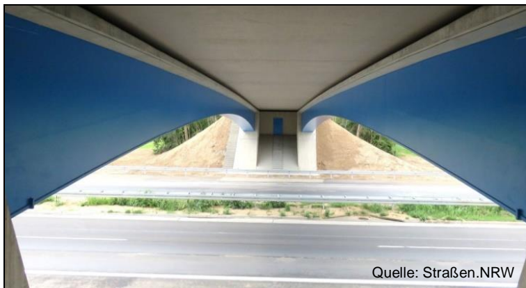
Bild 5: Untersicht des fertigen Überbaus
