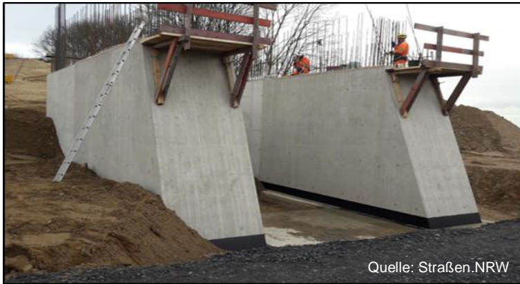
Bild 1: Flügel-scheiben beim aufgelösten Widerlager
