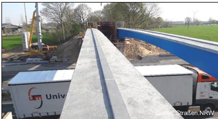
Bild 2: Verbundrahmen als Haupttragsystem
