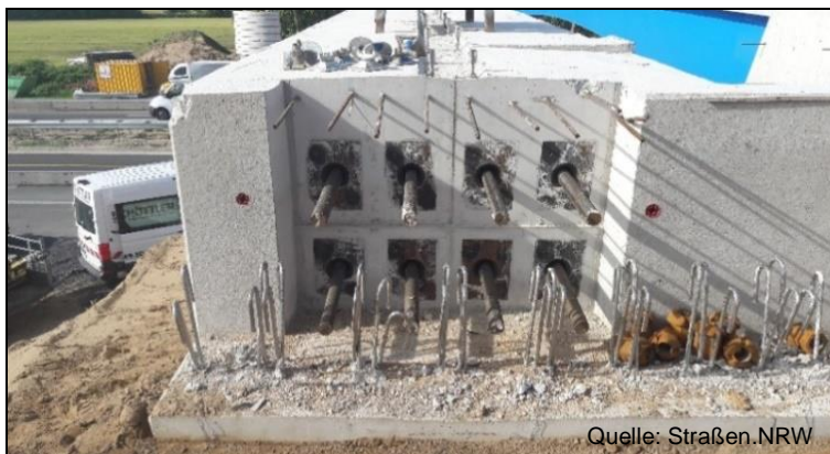
Bild 3: Verankerung der Stabspannglieder
