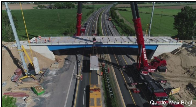
Bild 4: Montage der Plattensegmente
