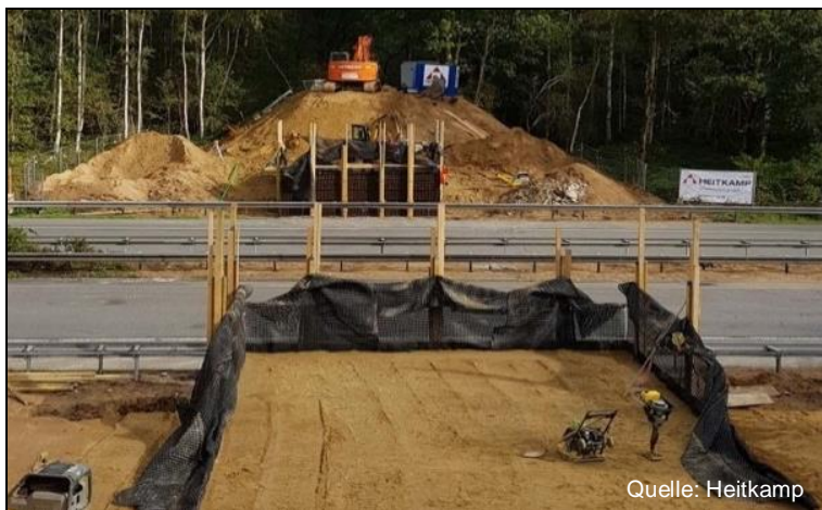
Bild 3: Herstellung der geokunststoff-bewehrten Widerlager
