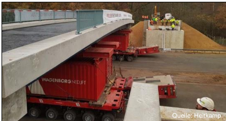
Bild 1: Einschleppen des Brückenüberbaus
