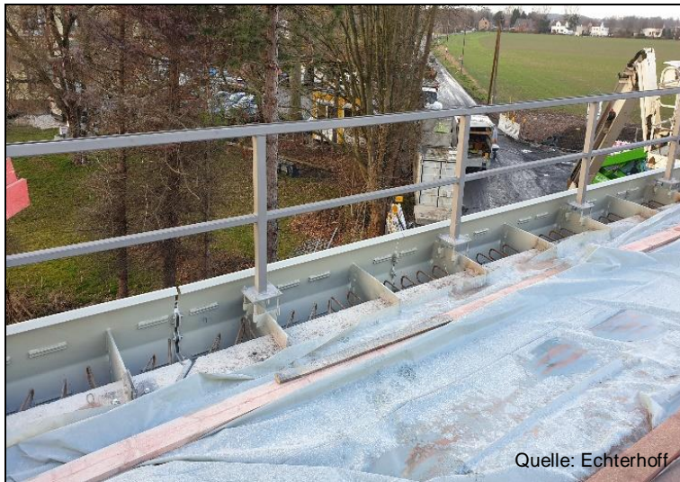
Bild 3: Montierte Hybridkappe
