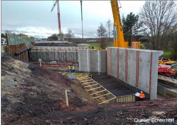
Bild 1: Gekoppelte Vollfertigteile bilden die Flügel
