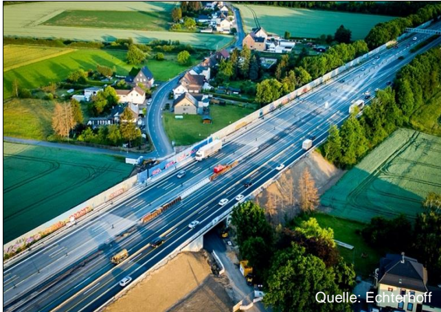
Bild 4: Überführung der Bundesautobahn A 1 über den Afferder Weg (ca. 8,5 Monate nach Baubeginn)
