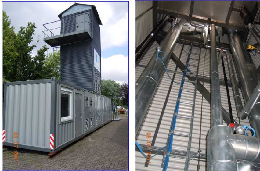
Abbildung 18 Pilotanlage in Altenrhein, Kanton St. Gallen in der Schweiz; die Rohrleitungen im rechten Bild zeigen die Synthese und Destillationskolonne (Bild: © Armin Grässli / Silicon Fire, 2011)
