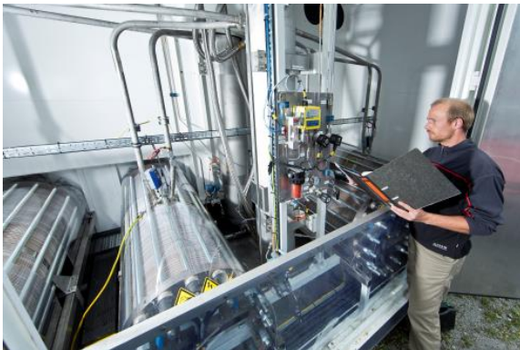
Wartung einer Elektrolyseanlage (ZSW)
