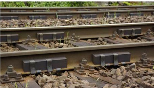
Abbildung 11. Schienenstegdämpfer [31]
