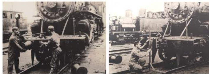
Abbildung 3: Umrüstung einer japanischen Lokomotive von der SK auf AK-Typ „Janney“
